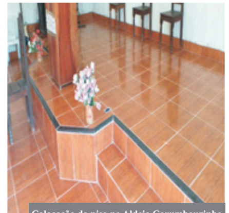
Colocação do piso na Aldeia Corumbauzinho
